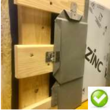
Standartlara uygun 2 cm havalandırma kesiti
