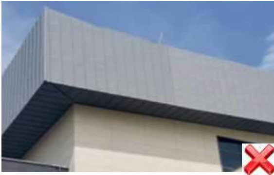
Aynı cephede "farklı" lot'lardan üretim yapılmış paneller
