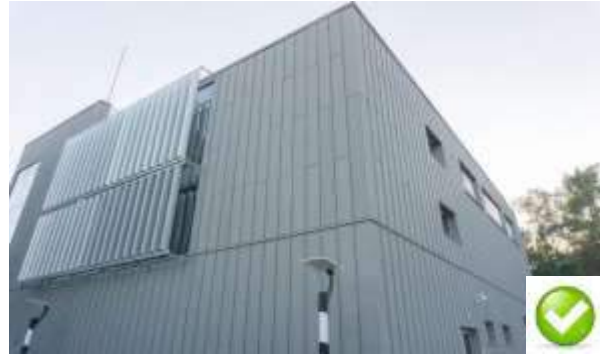
Farklı cephelerde aynı lot'lardan üretim yapılmış paneller
