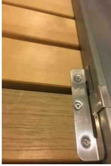
Hareketli klipsler ahşap alt yapıdan bağımsız çalışır.
