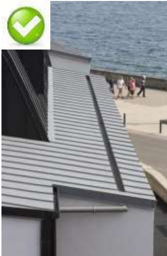
Çatı ve oluklarda eğim prensibine %100 uyulmuştur.
