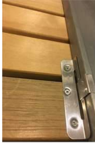
Hareketli klipsler ahşap alt yapıdan bağımsız çalışır.
