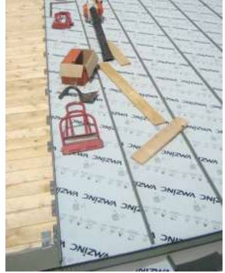
Hareketli klipsler saçak ucunda daha sık kullanılmalıdır.
