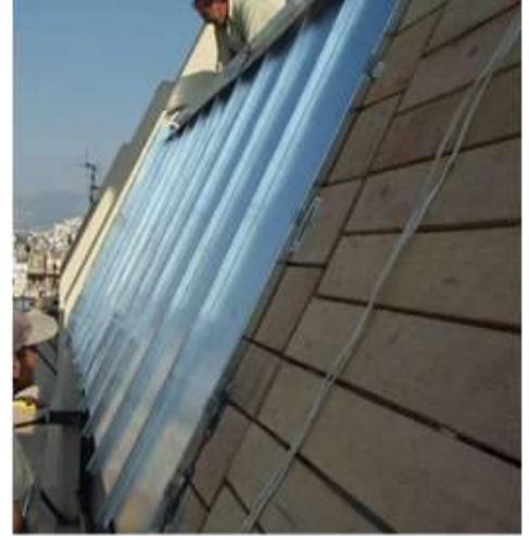
Vida başları potluğa sebep olmayacak şekilde, ahşapla hemyüz olmalıdır.
